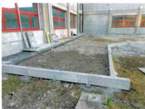
**11) Posa in opera di pavimentazione in autobloccante , compreso il risino e stesura di feltro tessuto non tessuto sottostante ; e la sabbia fine di stuccatura sovrastante , ad esclusione della fornitura dei mattoncini già presenti in cantiere.**
