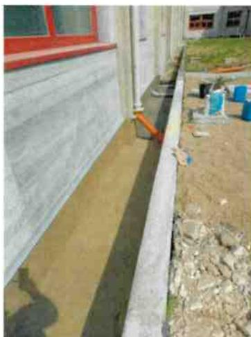
**21) Posa marciapiede, muratura chiusini, stesura stabilizzato, posa pavimentazione.**
