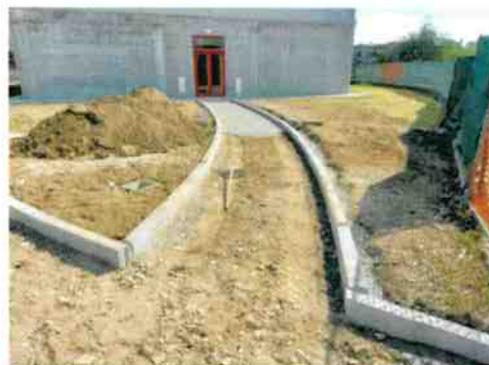
2)Realizzazione di massetto spessore medio 10 cm , tirato sottoriga sui cordoli a lasciare spessore per futura pavimentazione in autobloccanti , con interposta rete elettrosaldata maglia 15x15 diam 5 mm .
