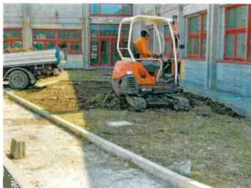
**8) Scarifica di terreno per un tratto di strada di circa 100 mq , con sistemazione del materiale in eccesso in loco , eseguito con escavatore e camion .( 1 gg camion + 1 gg escavatore ) .**
