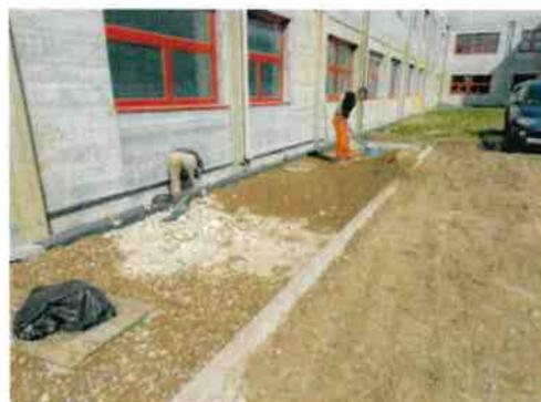
**-)Posa in opera di pavimentazione in autobloccante , compreso il risino e stesura di feltro tessuto non tessuto sottostante ; e la sabbia fine di stuccatura sovrastante , ad esclusione della fornitura dei mattoncini già presenti in cantiere.**
