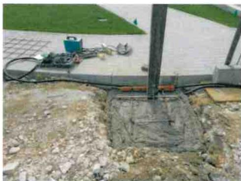
**16) Scavo per posa tubazione diam. 90 mm per collegamento pozzetto cancello grande sino al primo pozzetto utile per collegamento linea elettrica (c.a. 25 ml) compreso il reinterro finale .**
